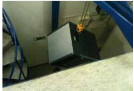
Abb. 12: Tiefste RRZE-Baustelle: Austausch des Core-Routers Tel22 in der Telefonzentrale des Klinikum mit Flaschenzug
