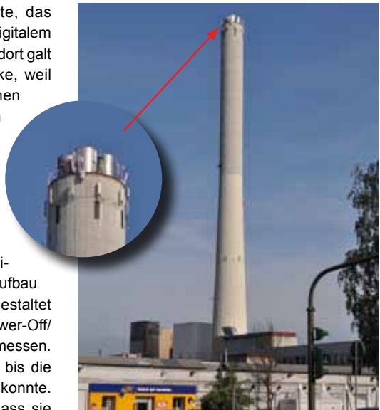
Abb. 10: Höchste RRZE-Baustelle: Kaminspitze mit Richtfunkantenne
