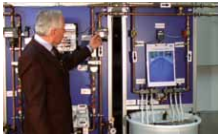
Abb. 17: Akademie für Lehrerfortbildung: W. Kichensteiner erläutert Aufbau und Funktion einer Wärmepumpe
