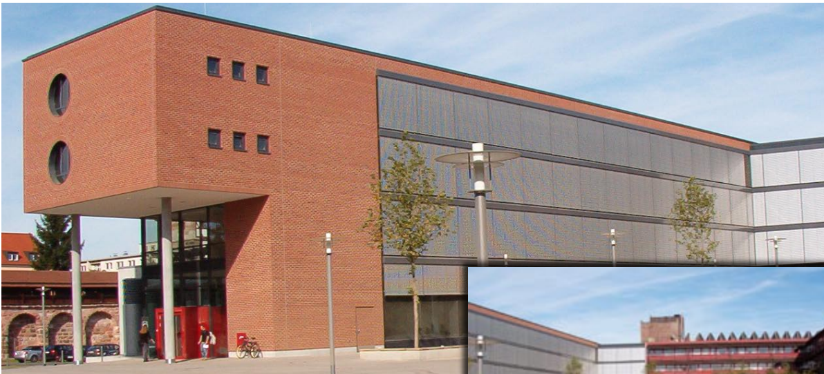
Die dringenden Platzprobleme konnten mit dem Neubau behoben werden.
