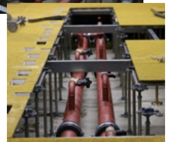
Verrohrung im Doppelboden für die Kaltwasserversorgung
