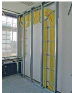
>> Neu verlegte Leitungen <<
