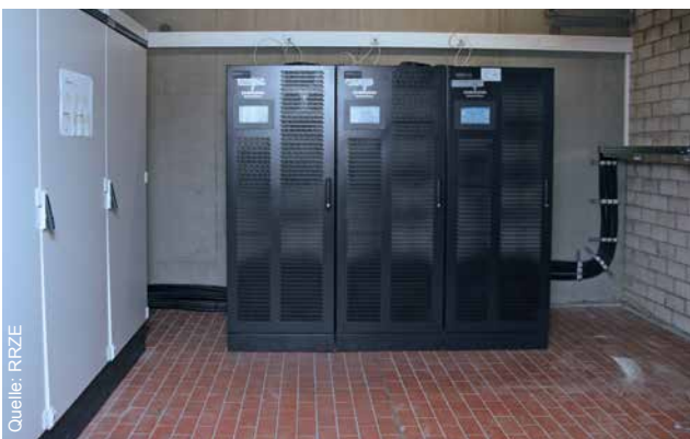
Neue USV-Anlage mit drei Schränken ...
