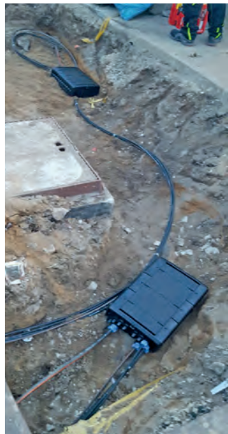
Reparatur (Spleißbox) eines beschädigten FAU-Datenkabels in der Erwin-Rommel-Straße
