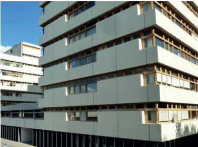
E-Technik, Cauerstraße, Gebäude 115; Quelle: Staatl. Bauamt Erlangen-Nürnberg
