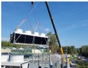
Einbringung eines weiteren Rückkühlwerks auf das Dach der Technikzentrale der Naturwissenschaftlichen Fakultät.
