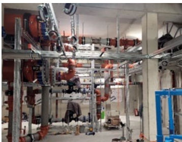
Sommer 2021: Infrastrukturarbeiten in der Technikzentrale der Naturwissenschaftlichen Fakultät zur Vorbereitung der Kopplung von „Fritz“.
